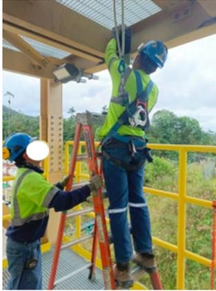
Descripción. Utilización de escaleras en trabajos en alturas, con acompañamiento de otra persona y uso de equipo anticaídas.
