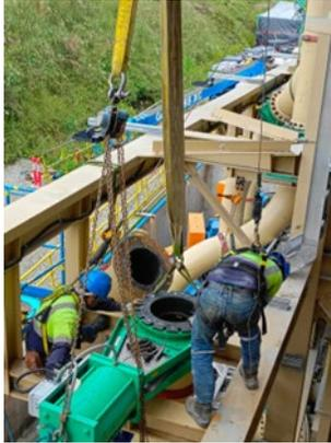
Descripción. Colocación de una válvula sobre una estructura metálica a 5 metros de altura
