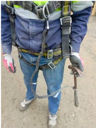
Descripción. Trabajador utilizando sujetador de herramientas para realizar trabajos en alturas
