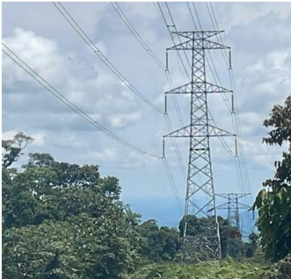
Nota. Fotografía de una línea aérea de alta tensión, oriente ecuatoriano, se aprecia cable conductor y franja de servidumbre desbrozada. Elaboración propia.
