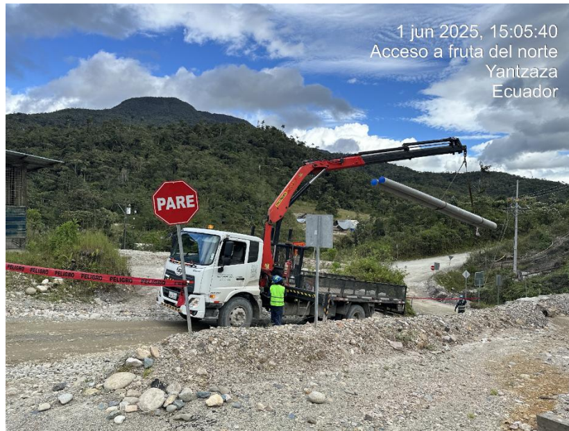
Descripción: Grúa articulada realizando un izaje simple
